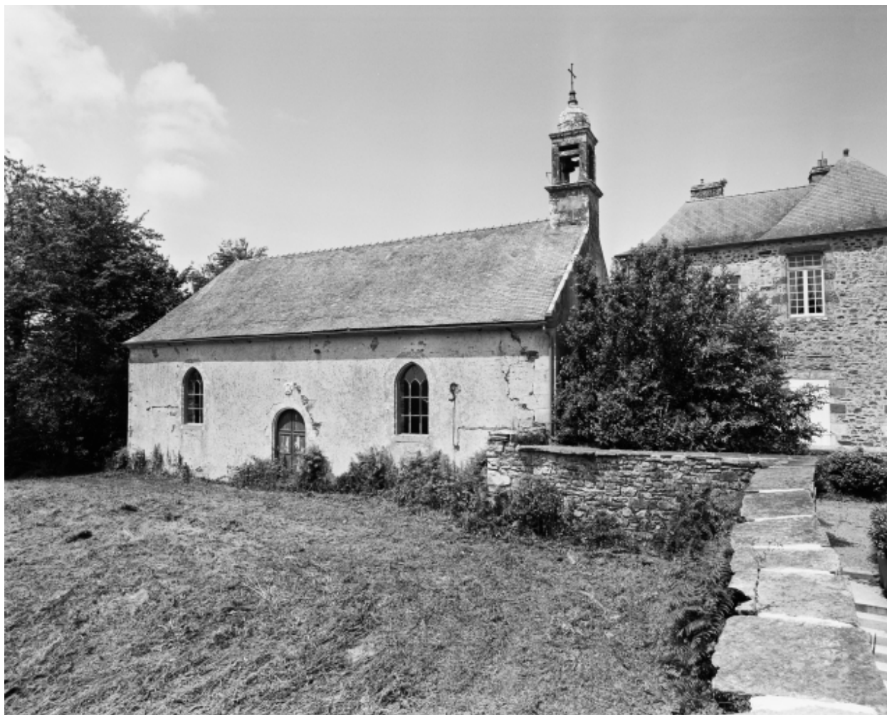
Chapelle, élévation sud
