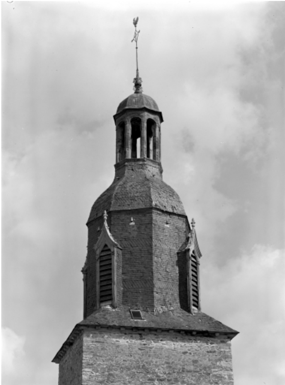
Clocher, détail de la toiture.
