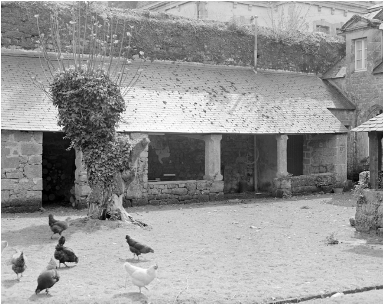
Cour intérieure, cloître, vue prise du nord. (1983)
