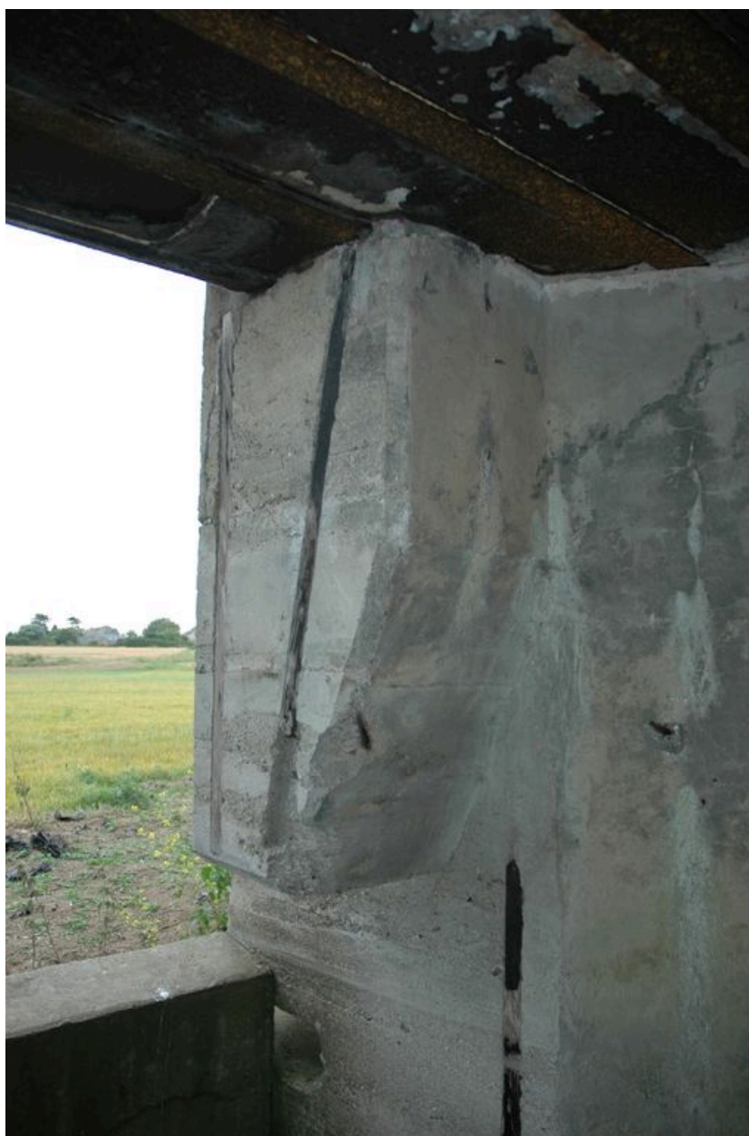
Vue de détail de l'embrasement de l'une des quatre casemates de type 669 (état en 2008)
