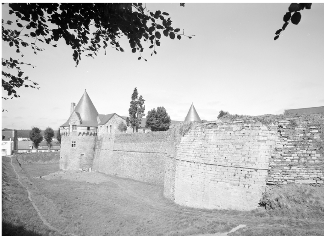
Courtine sud et fossé, vue générale sud-est.
