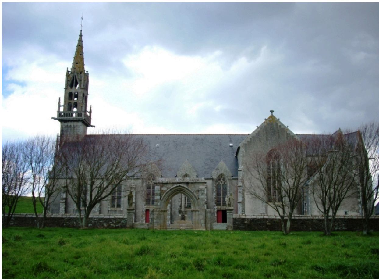
Plonévez-Porzay, chapelle Sainte-Anne-La-Palud : élévation sud
