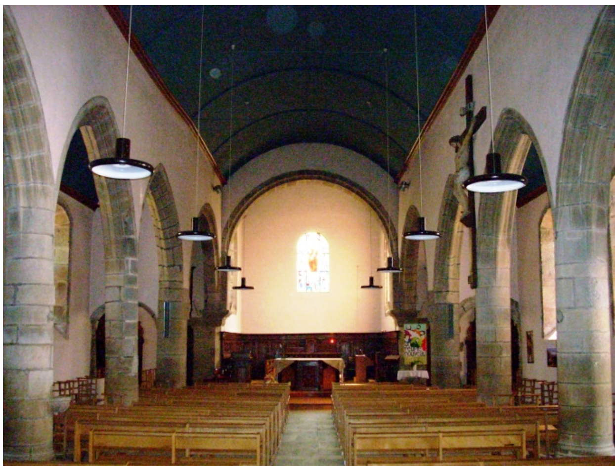
Guilers, église paroissiale : vue axiale est
