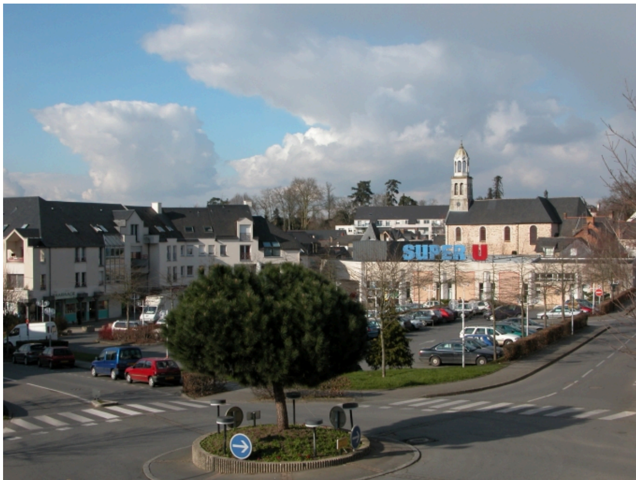
Vue de situation sud
