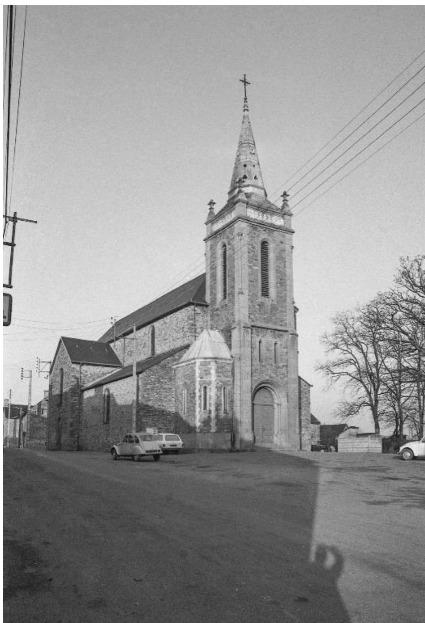
Façade prise du sud-est (état en 1973)
