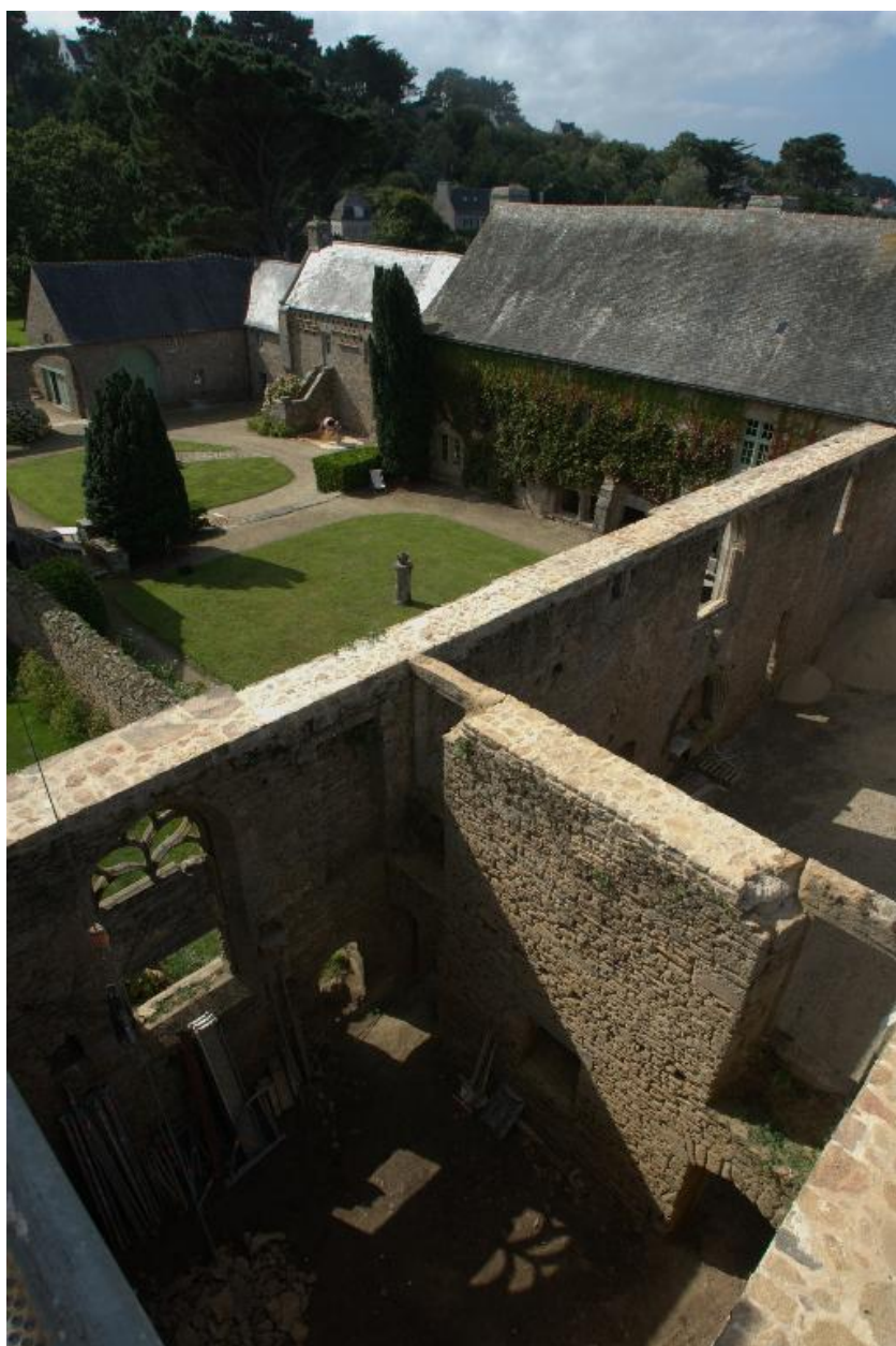
Vue au premier plan de l'ancienne salle capitulaire du couvent
