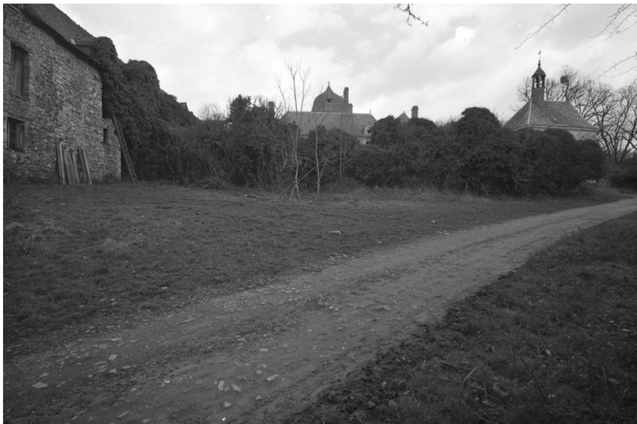
Vue de situation sud prise du chemin d'accès.
