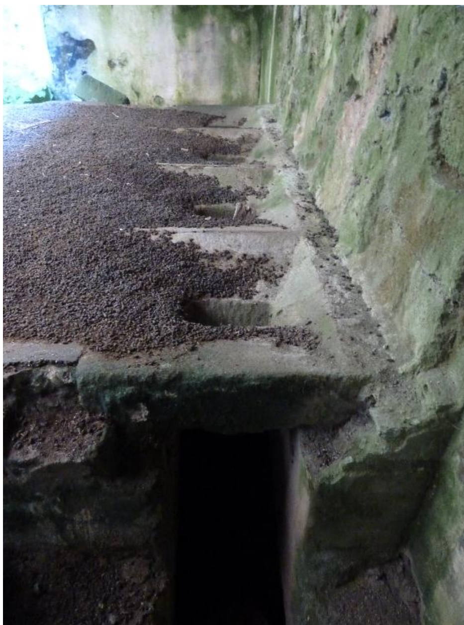
Hœdic, fort central, caserne à l'épreuve, latrines.
