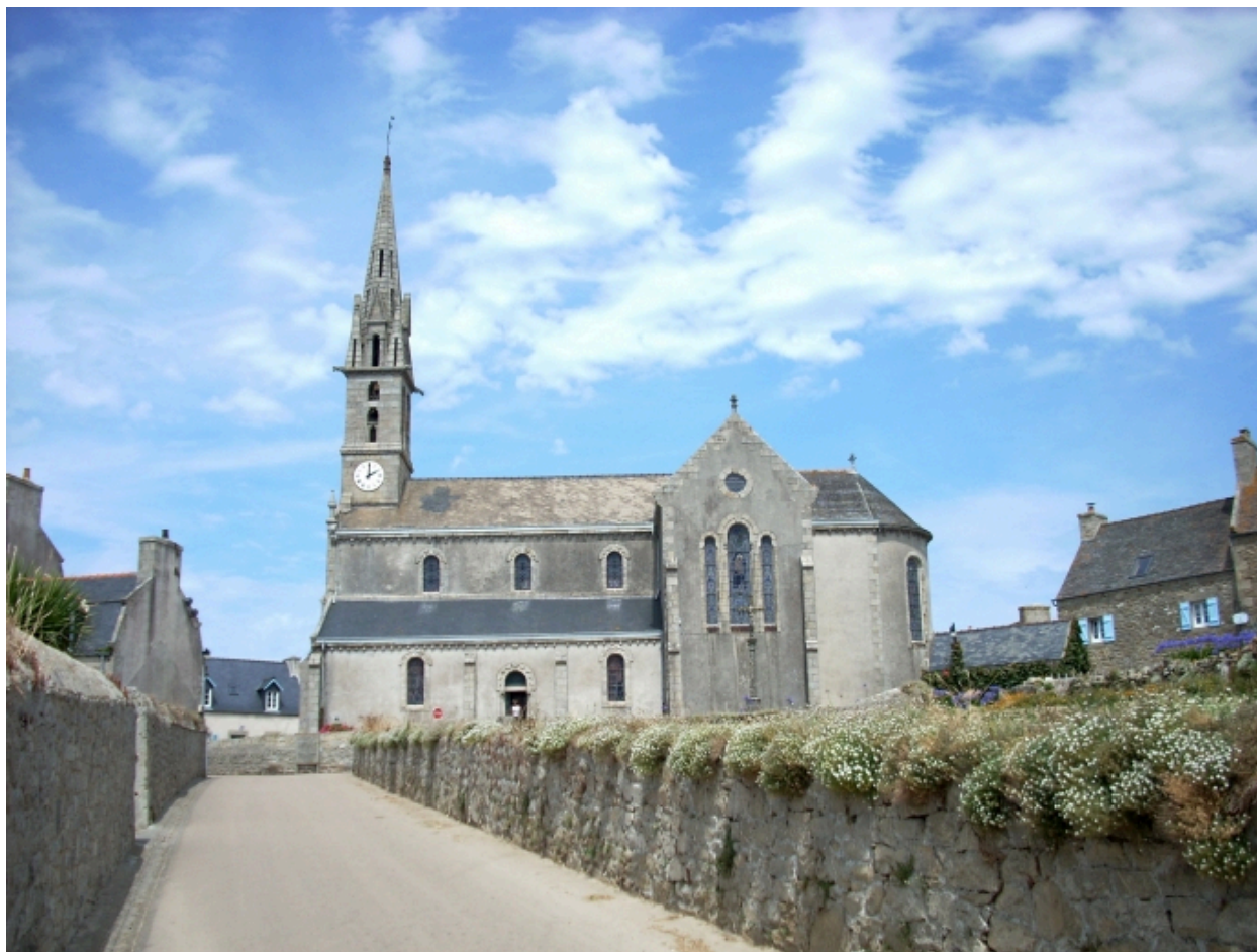
Ile de Batz, église paroissiale Notre-Dame : vue générale sud
