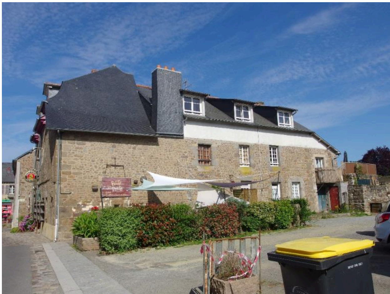
Vue de la façade est
