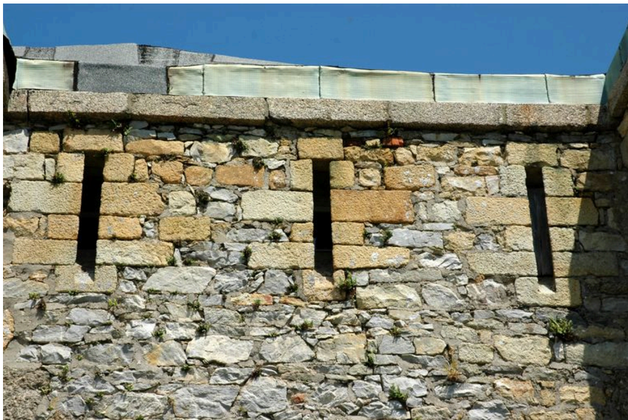
Vue du corps de garde crénelé : créneaux de fusillade du parapet (état en 2005)
