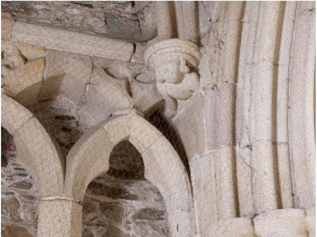
Porche sud. Détail du décor d'arcatures évidées détachées des parois latérales et de la retombée de la voûte sur un culot figuré
