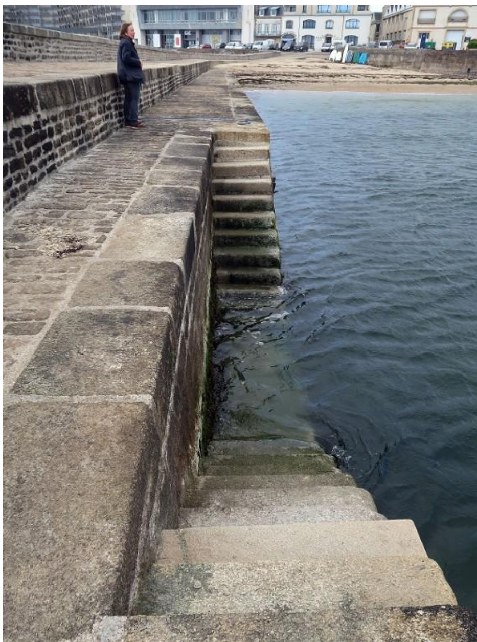
Môle de la Croix, escaliers
