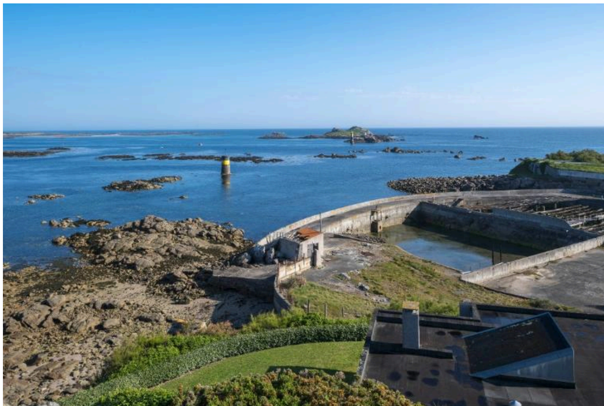
Le balisage du chenal d'accès et les viviers de Sainte-Barbe
