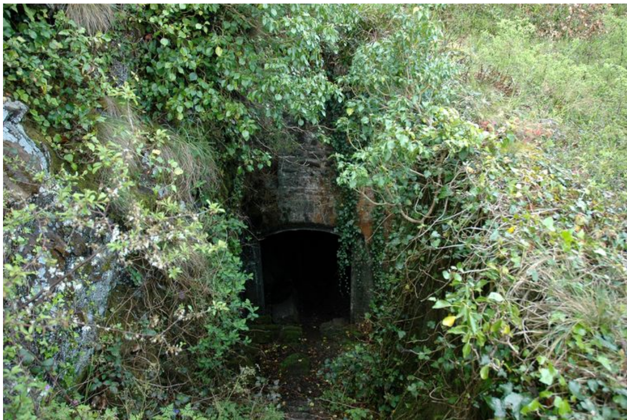
Vue de l'entrée de l'escalier envahie par la végétation (état en 2006)
