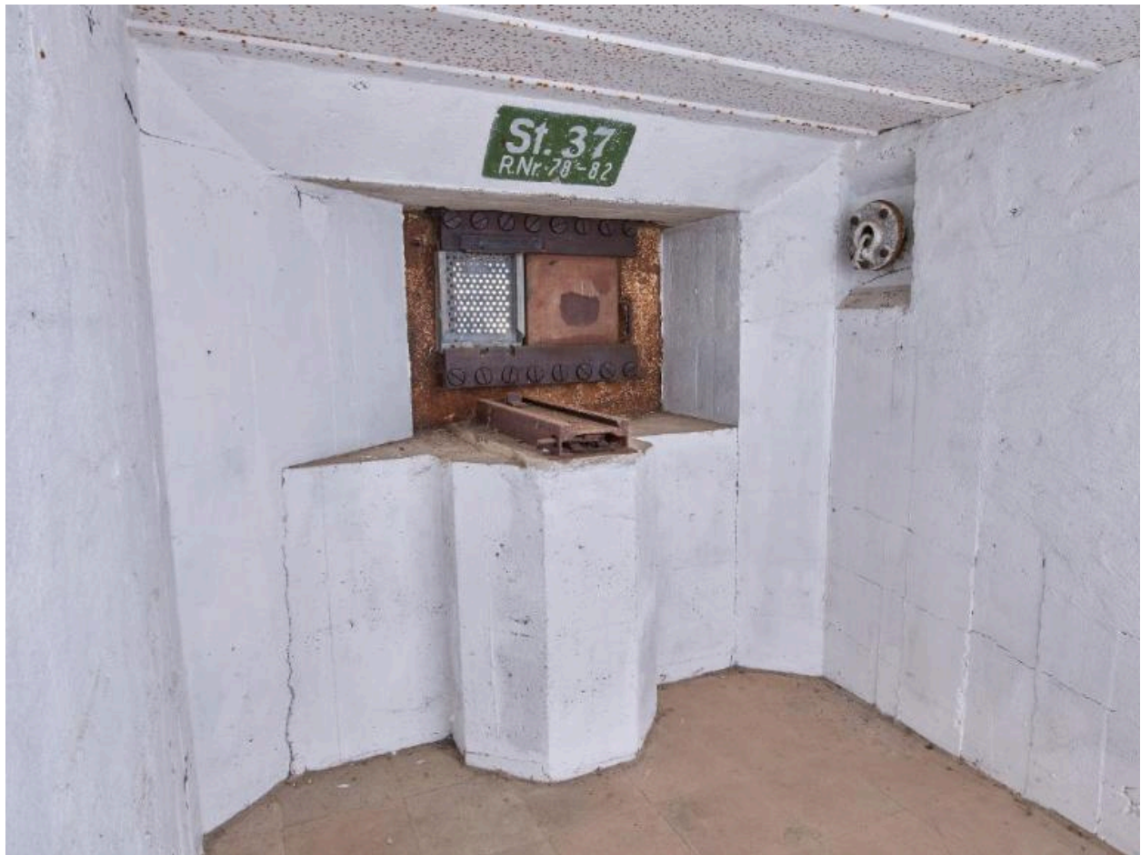
Vue de la chambre de combat : support d'affût de la mitrailleuse et créneau blindé (St. 37). Au-dessus du poste de tir, cartouche avec marquage. A droite, clapet de surpression du système de ventilation
