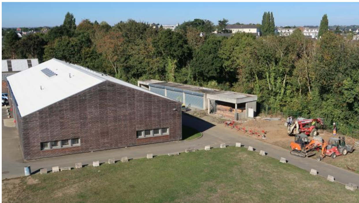
Bâtiment I : atelier EMAT et stockage, vue prise depuis l'est.
