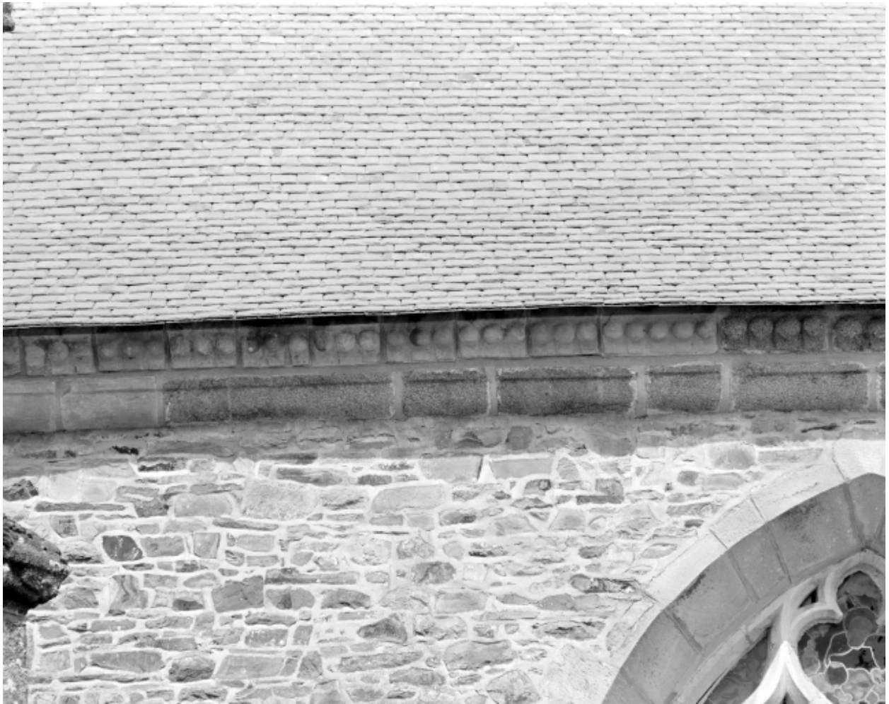
Elévation sud, mur sud du choeur, détail de la corniche.
