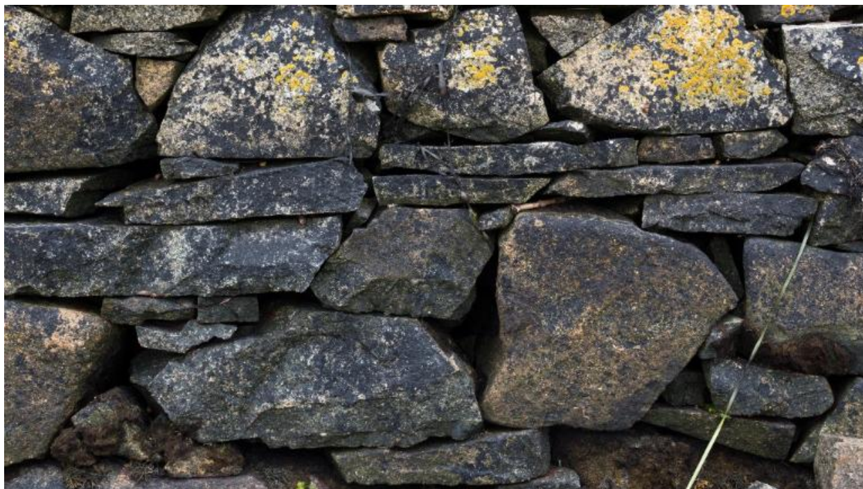
Détail d'une couche de moellons plats d'un mur de soutènement du Keraret
