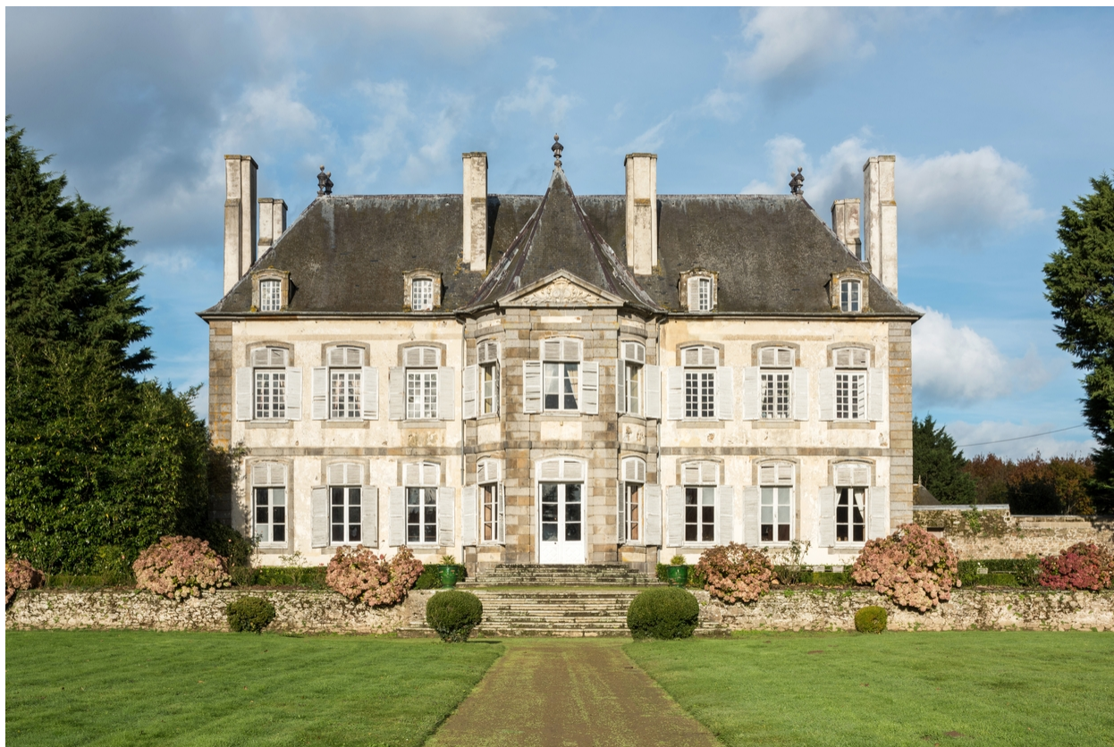
Façade méridionale sur le jardin, vue générale
