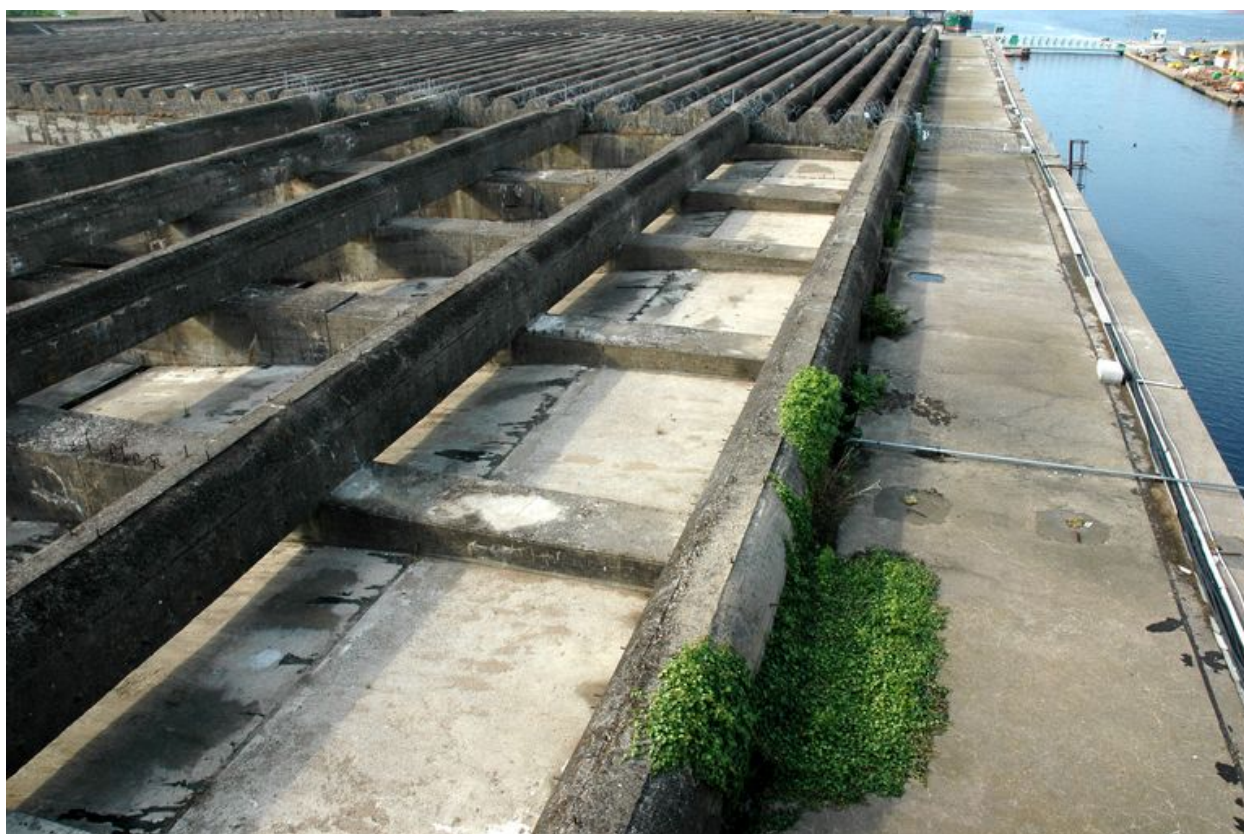
Vue de la structure de type Fangrost restée inachevée
