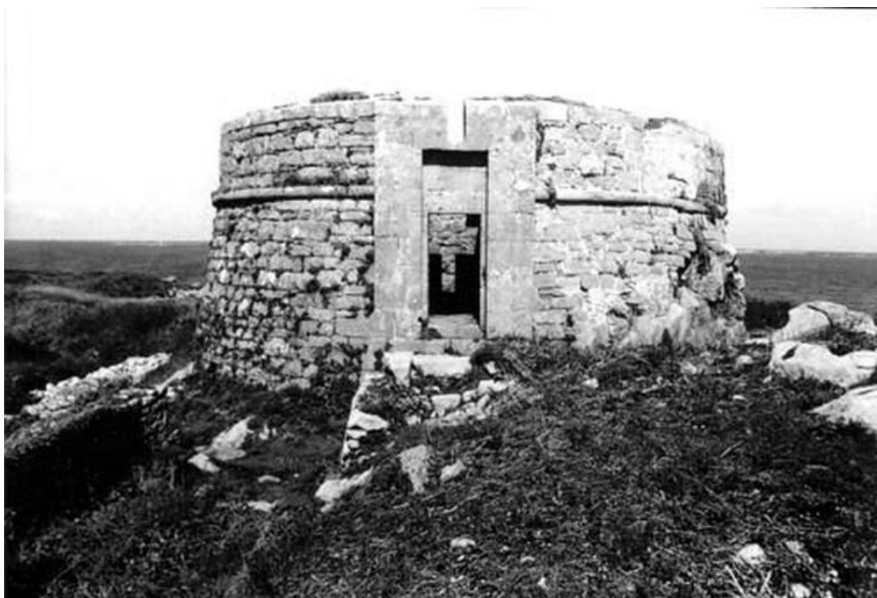
Landéda : vue de la tour d'artillerie du fort Cézon, photo Association fort Cézon
