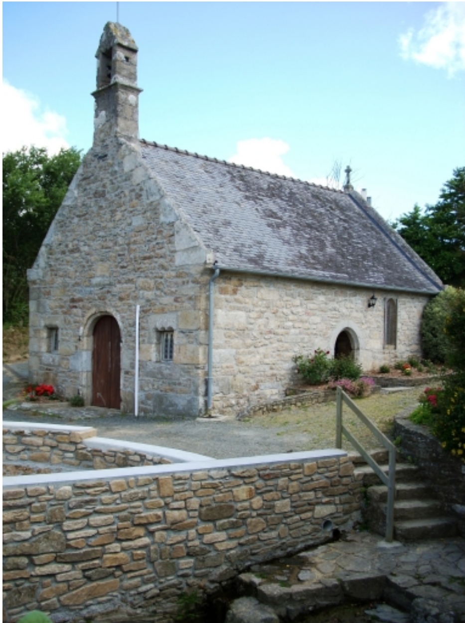
Kernouës, chapelle de la Clarté : vue générale sud-ouest
