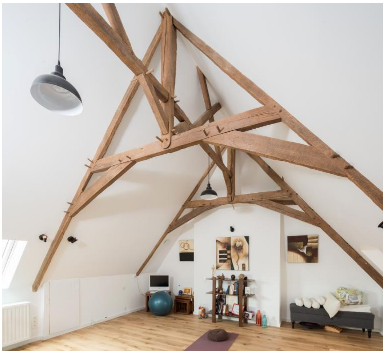
Logis, combles, vue générale de la charpente à double faîtage
