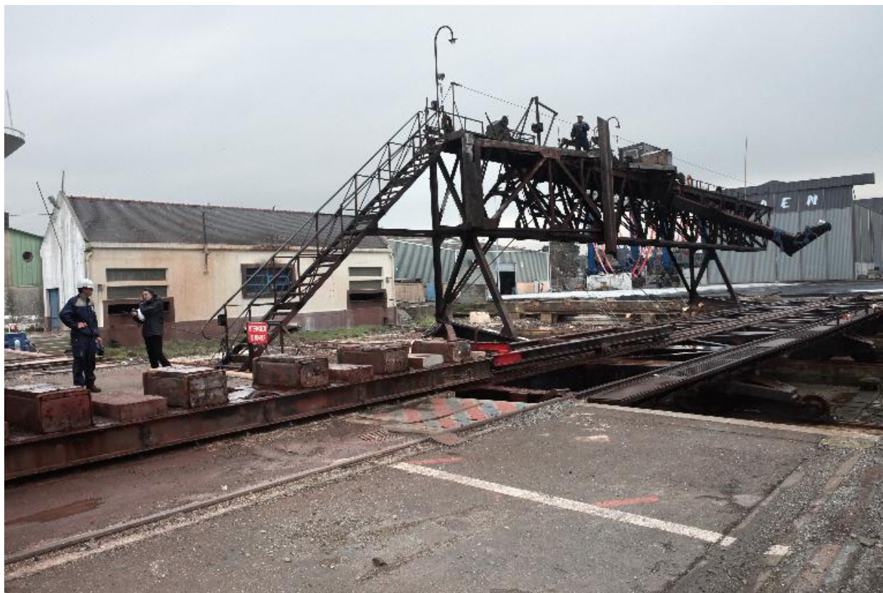
Passerelle sur slipway
