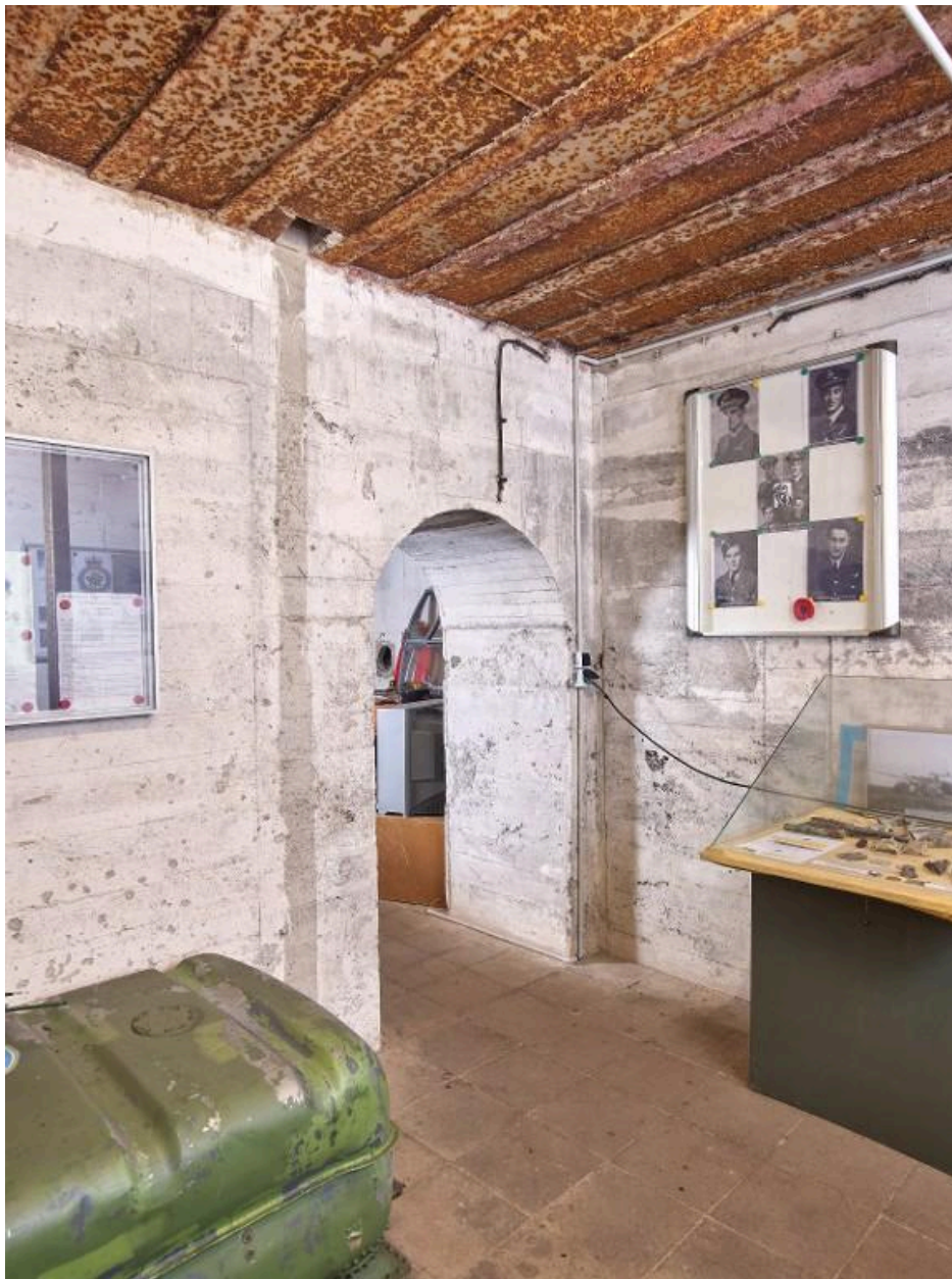
Vue intérieure : salle sud, porte en arc plein cintre (1,9 m x 1 m) donnant sur les salles situées au nord
