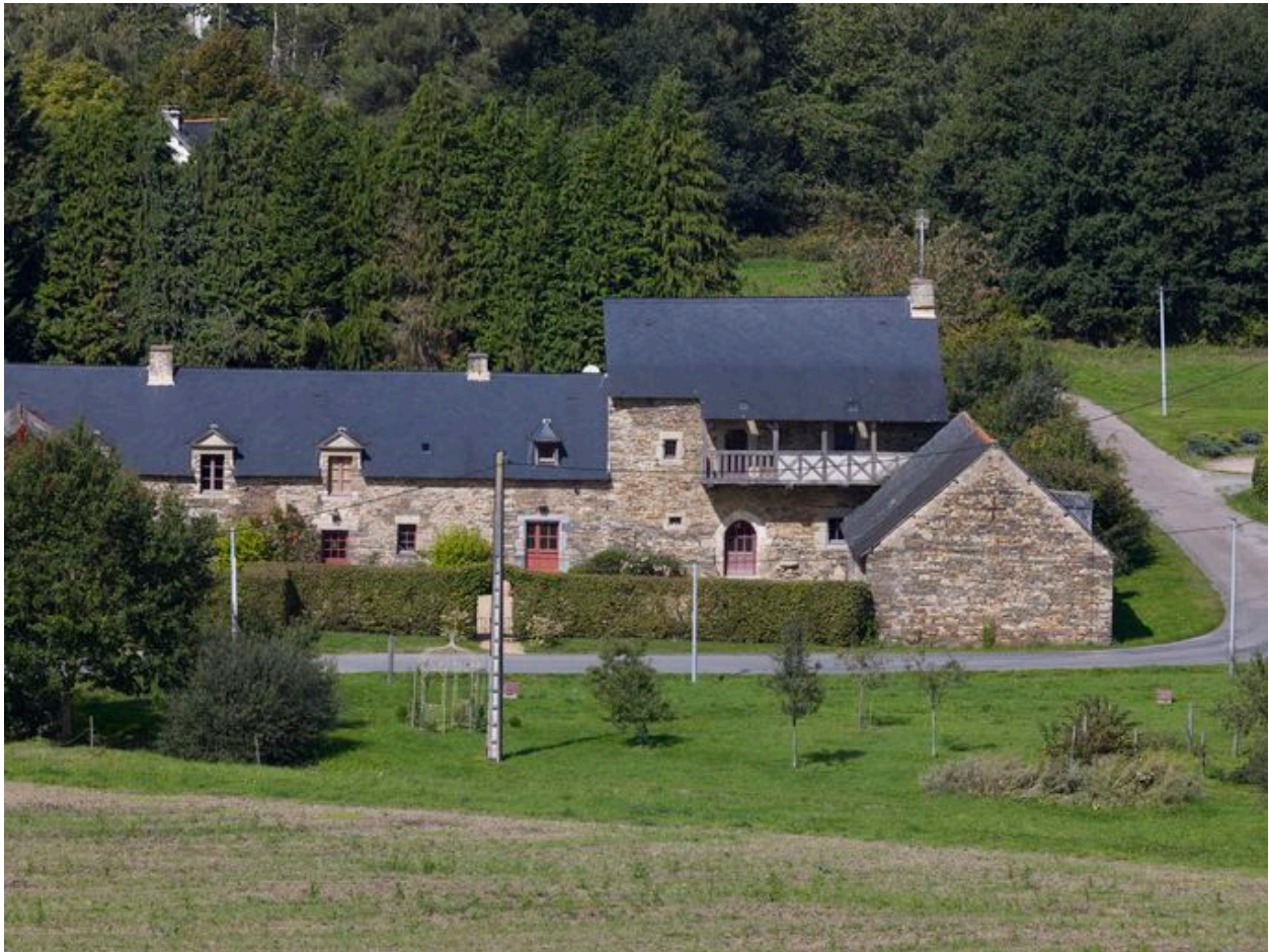
Manoir : vue de situation prise du sud (état en 2011)
