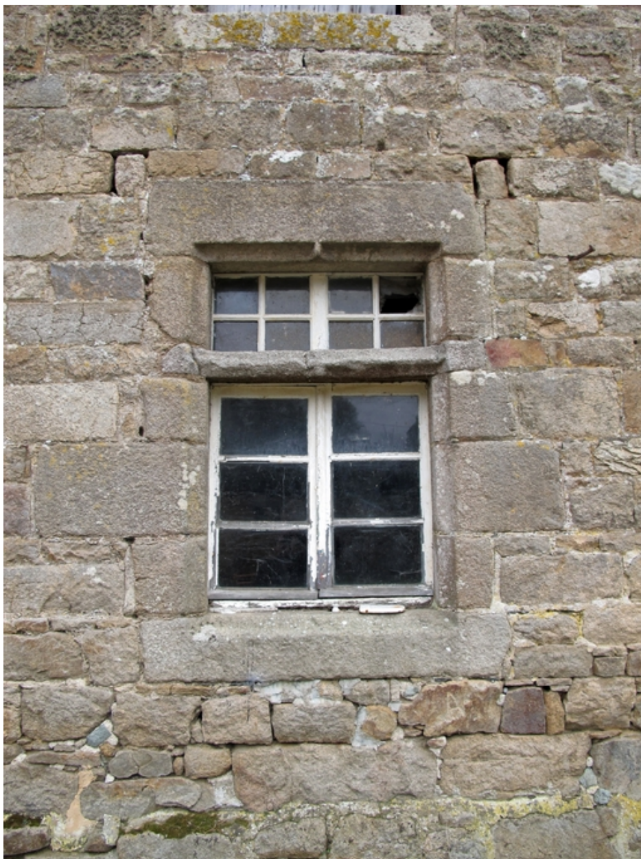
Vue de détail du logis : fenêtre à meneau et croisillon
