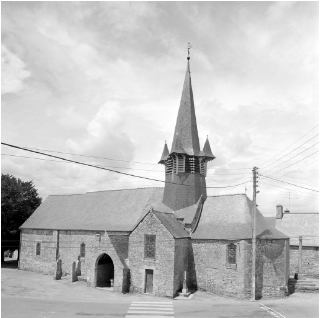
Elévation sud-est : vue générale
