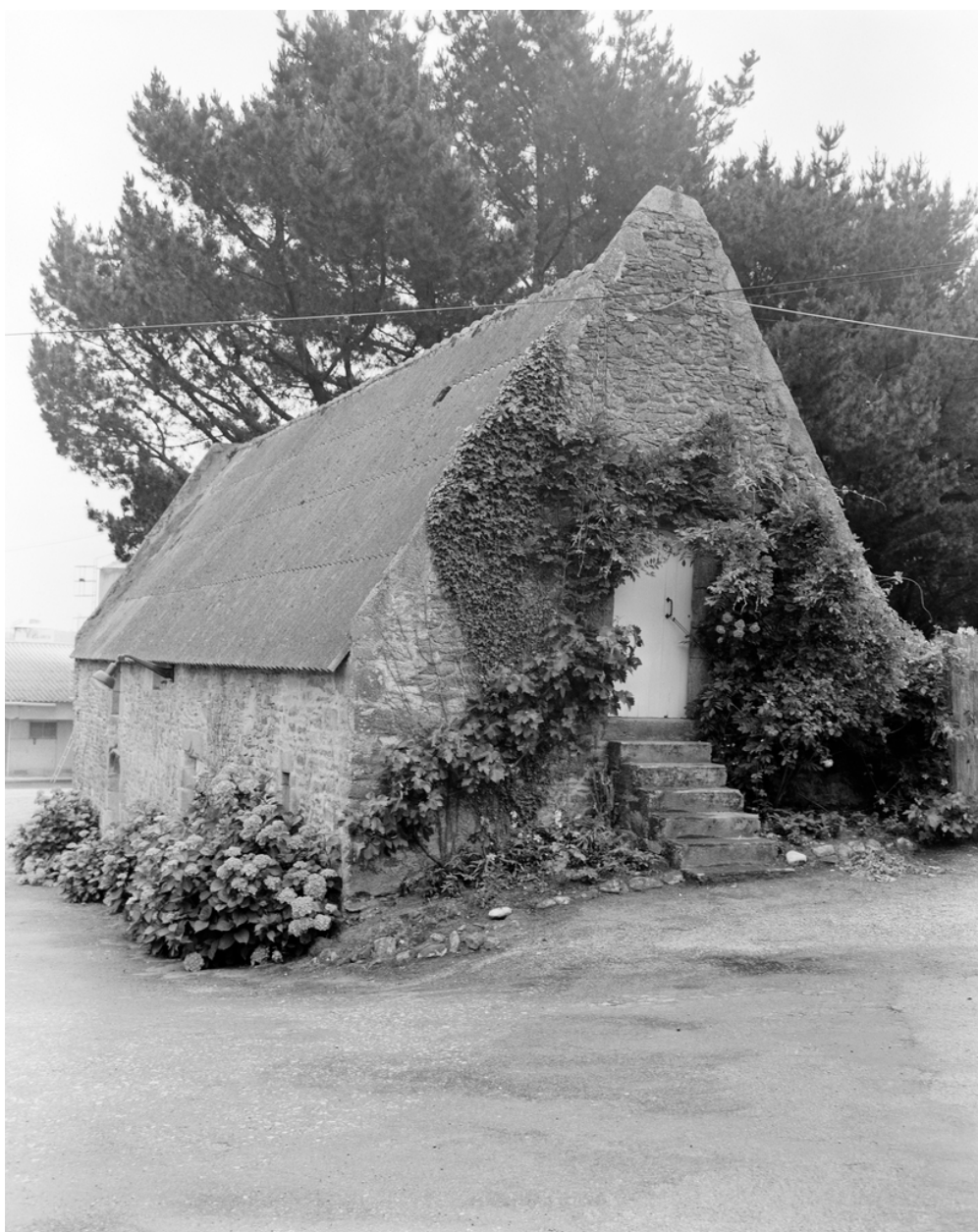
Keryvonnet. Cellier, vue générale ouest.
