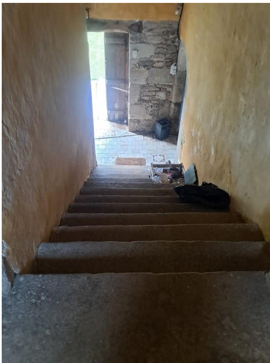
Escalier tournant à retours sans jour, vue du rez-de-chaussée
