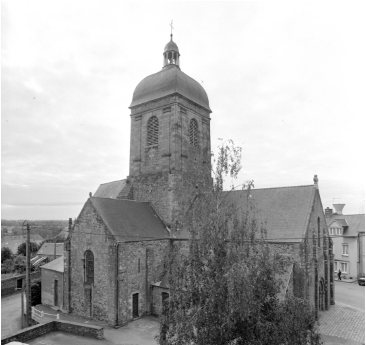
Elévation Nord : vue générale
