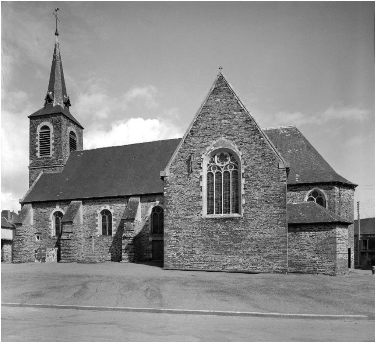
Elévation sud : vue générale (Etat en 1968)
