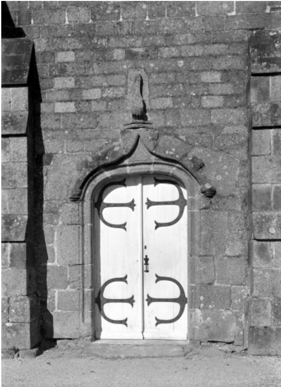
Elévation Sud, nef, porte : vue générale
