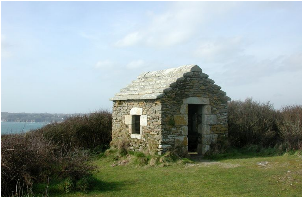
Locmaria-Plouzané : vue générale du corps de garde de Neiz Vran, le Moulin de Ru Vras
