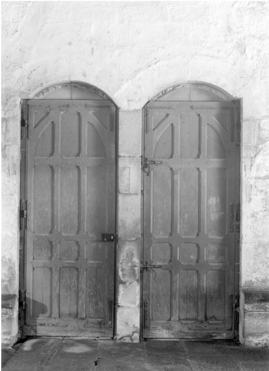
Mur sud de la nef, portes ouvrant sur le porche.
