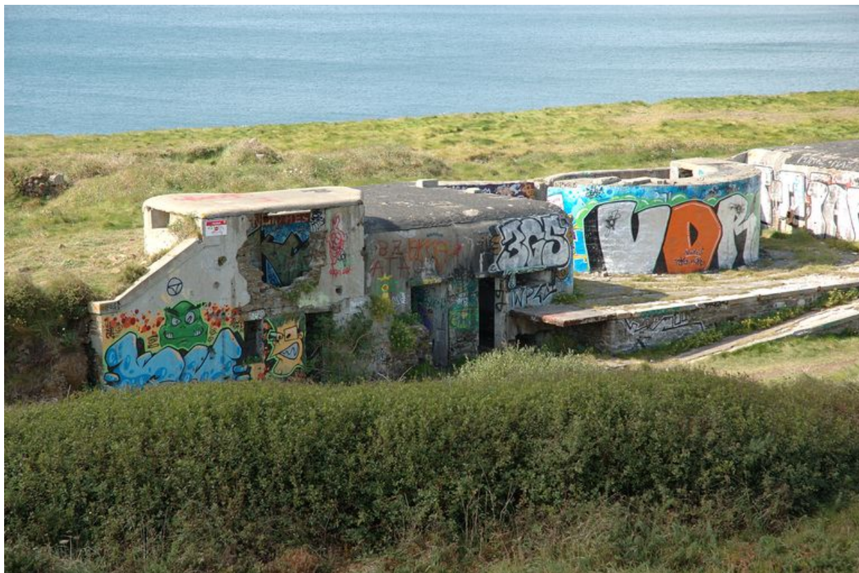
Vue du poste de commandement est et du premier emplacement de tir avec magasin de combat (état en 2007)
