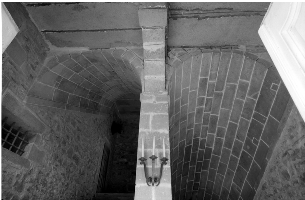
Voûtes de l'escalier et du couloir
