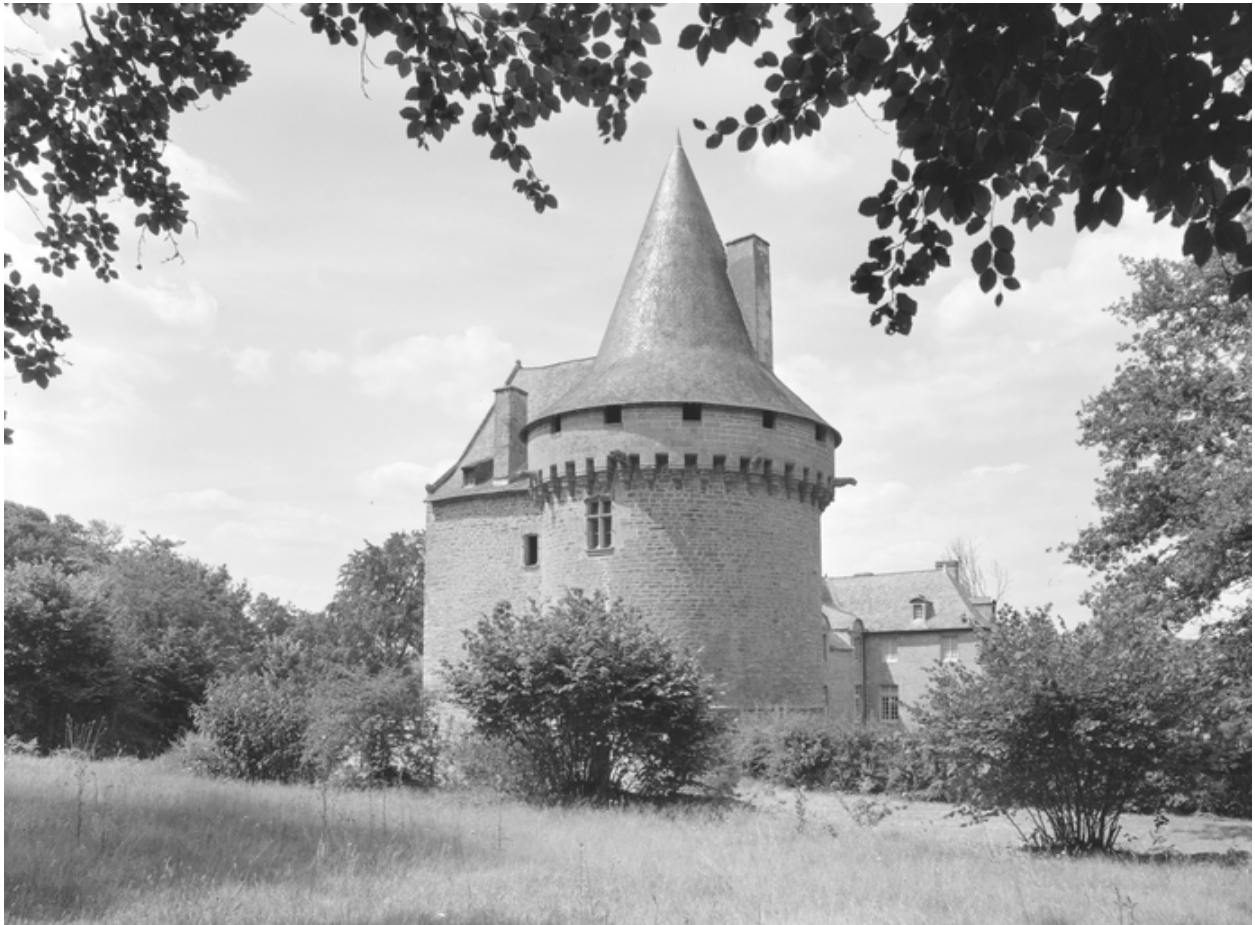
Elévation sud : vue générale prise du sud-est (état en 1984)
