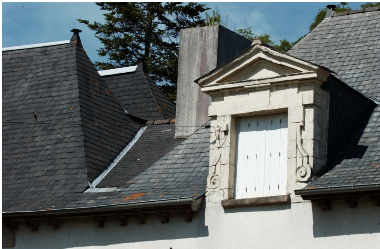
Lucarne en façade principale
