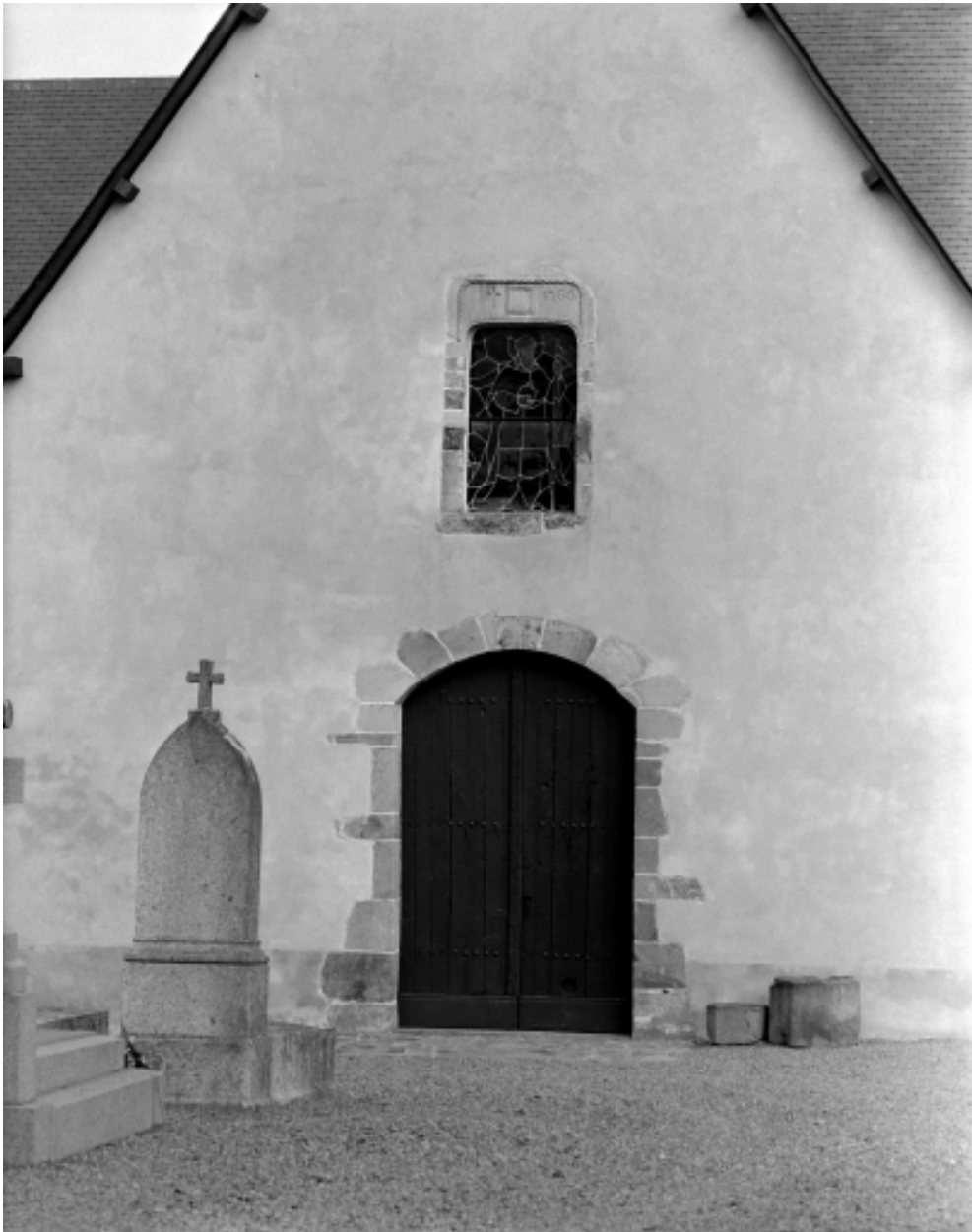
Elévation Ouest, porte : vue générale
