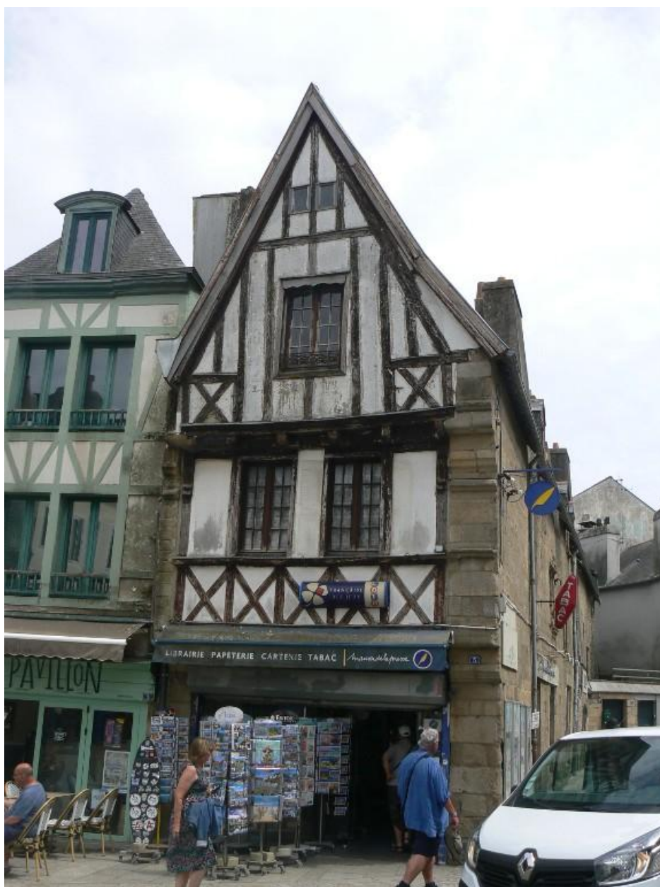
Façade à pan de bois avec encorbellement sur solives
