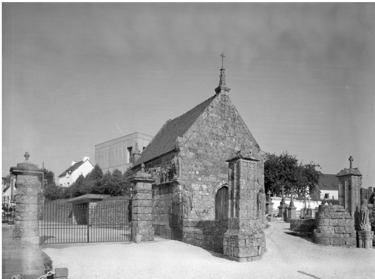
Vue de situation prise du nord ouest
