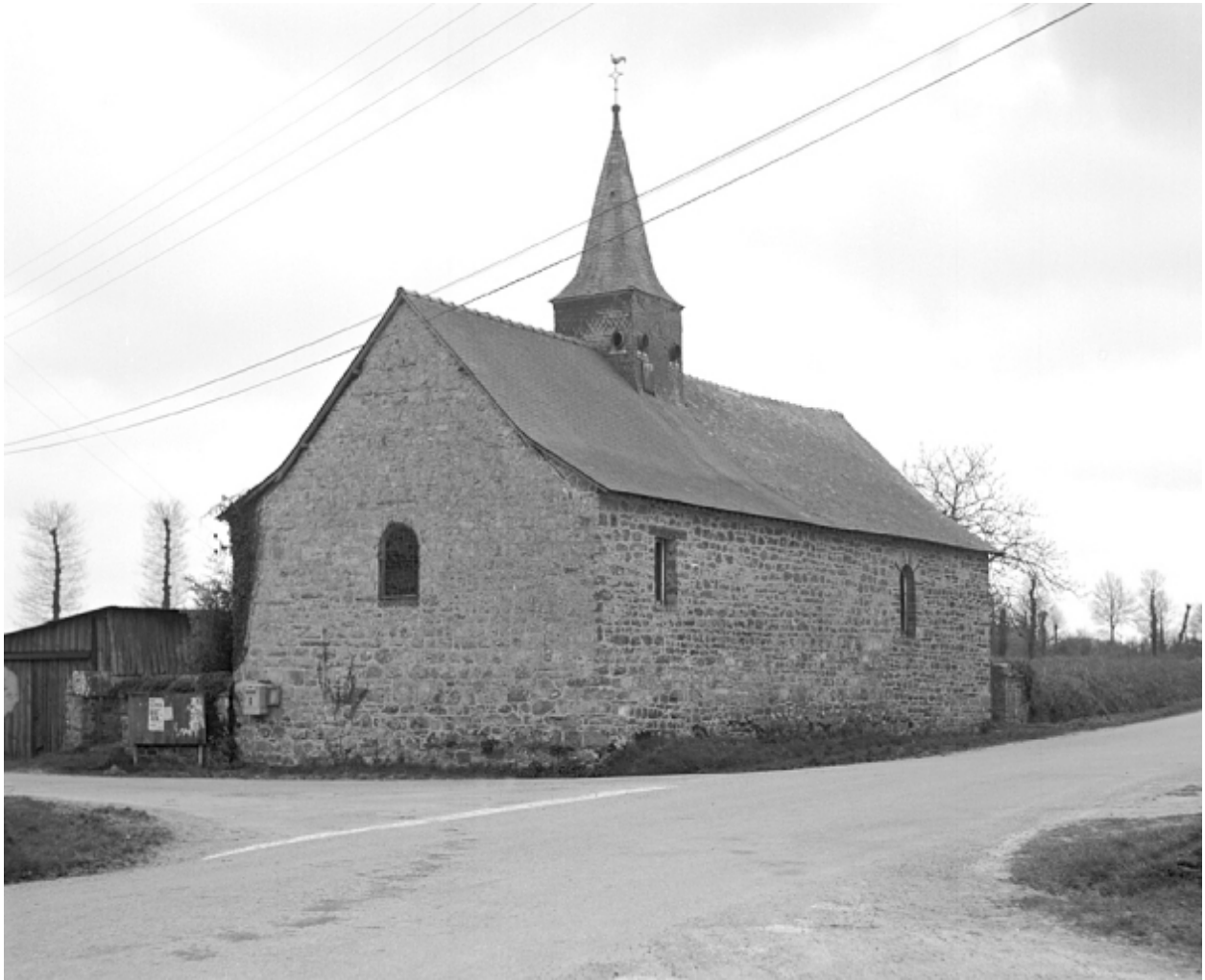
Vue générale nord-est en 1982
