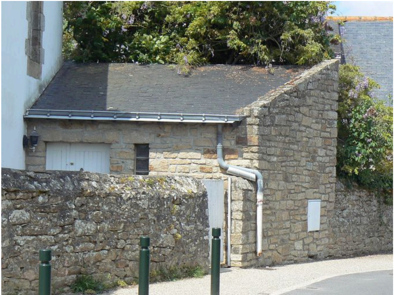
Appentis de la maison de capitaine du 12 rue de la Pointe du Bill
