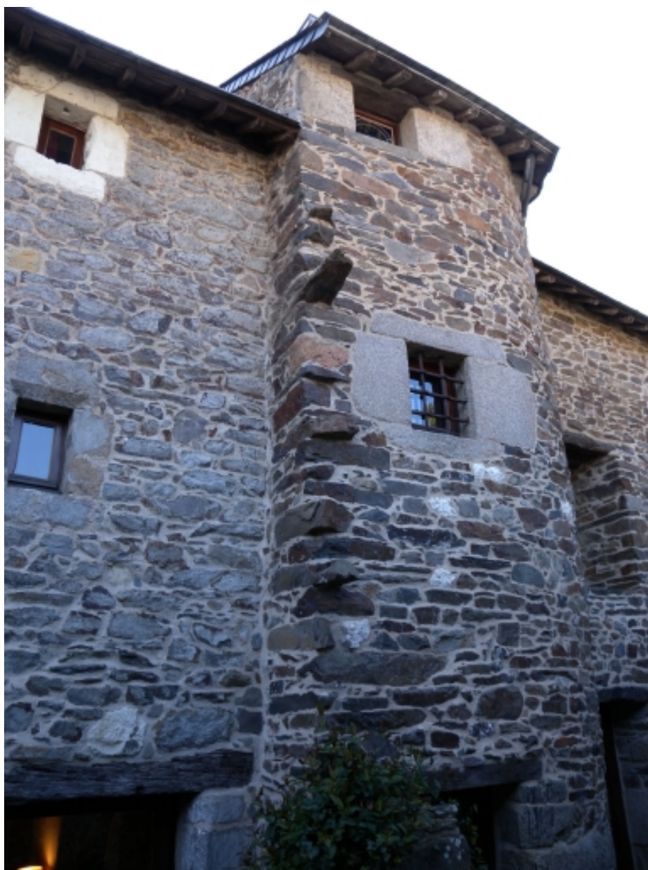
Tour enfermant l'escalier de distribution intérieur
